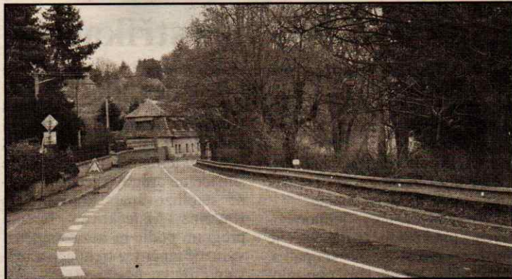
Tento úsek ve Lnářích u domů čp. 2 a 3 by měl příští rok projít opravou.
